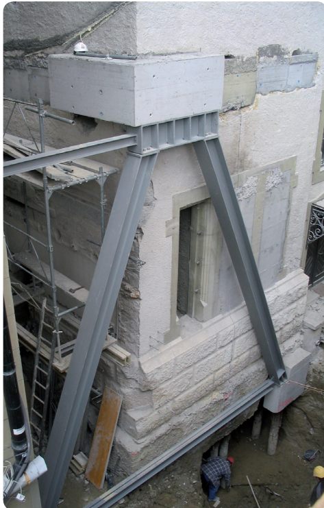
Stahlbock zur temporären Abfangung der Museumsfassade
